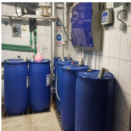
Рисунок 19 Система дозировки и система пополнения прачечного отсека
