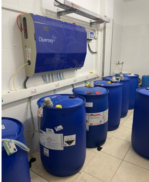
Şekil 20. Çamaşırhane Dozajlama Sistemi ve Refill Dolum Sistemi
